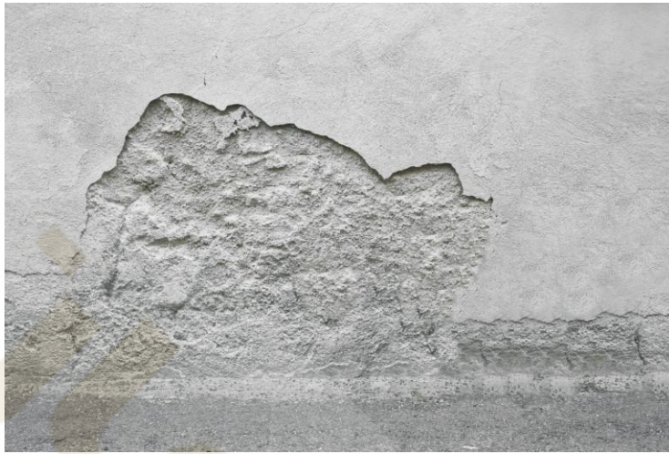
شکل ۲ تجزیه و پوسته پوسته شدن بتن
